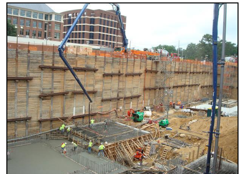
Photos: CMC Rebar
